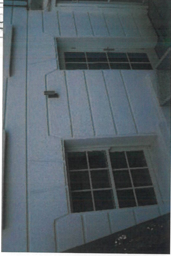
1.(d) Basement level front façade No 29.
